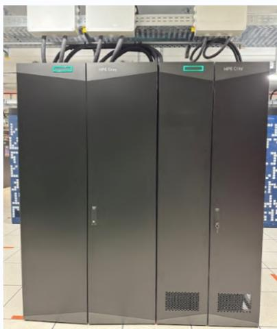
Dans le cadre de l'extension du supercalculateur ADASTRA, un CDU et un rack pour des nœuds de calcul ont été ajoutés (août 2024) et connectés sur les réseaux électrique et de refroidissement existants.
